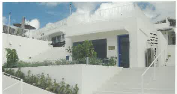
住宅、学校、店舗、事務所、工場、倉庫などの外装及び塗床
